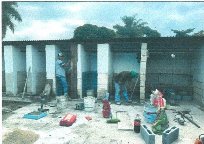
Foto 1: REPARACION DE BAÑOS
